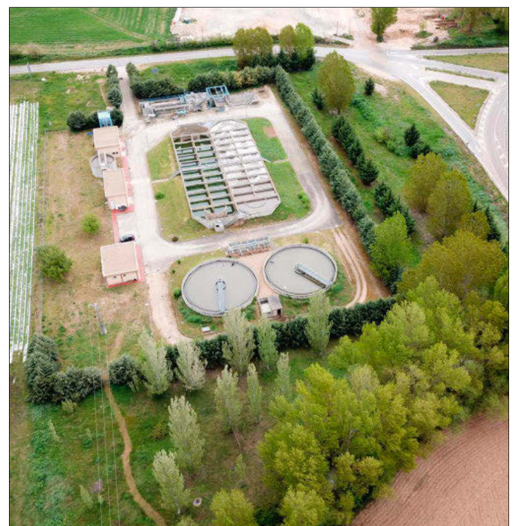
Estación depuradora de Almazán. HDS
